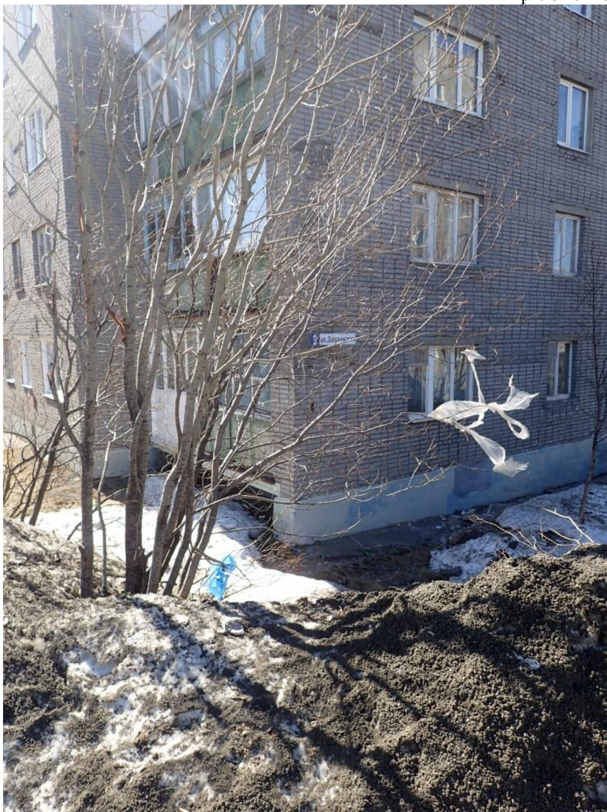
Удаление от угла здания около 20 см, высота размещения от земли более 3,5 м, размещено с левой стороны фасада.
