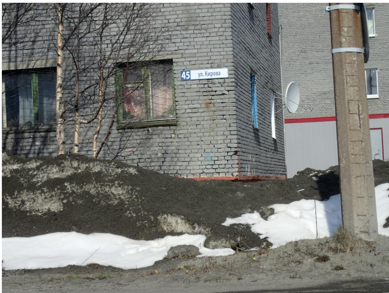
Удаление от угла здания около 10 см, размещено с правой стороны фасада.
