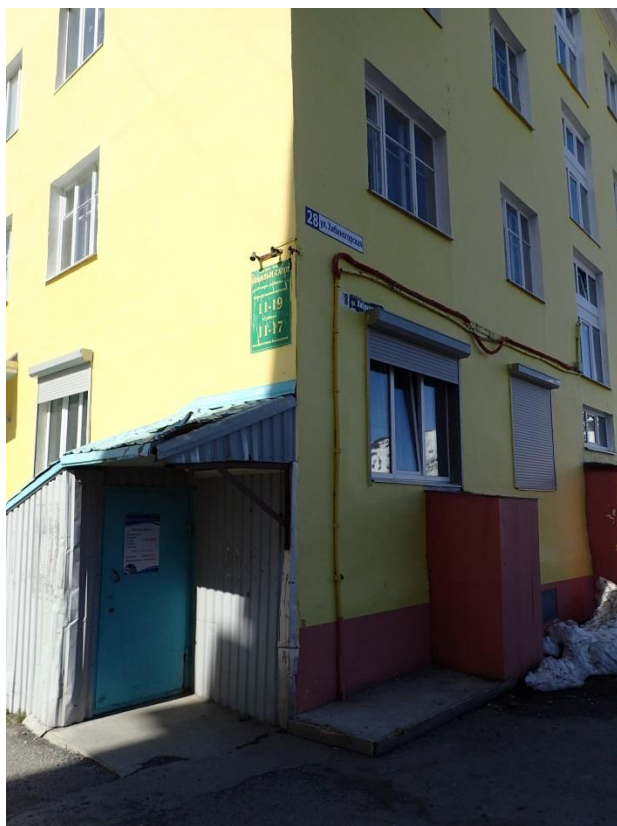
Удаление от угла здания около 20 см, высота размещения от земли более 3 м.
