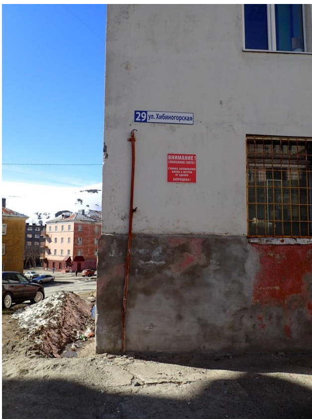
Высота размещения от земли более 3,5 м, размещено с левой стороны фасада.
