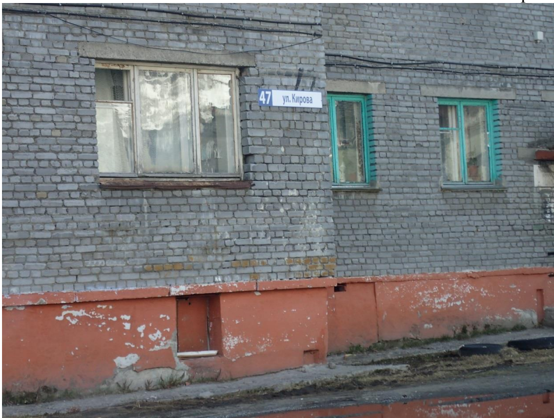
Удаление от угла здания около 5 см, высота размещения от земли более 3 м.
