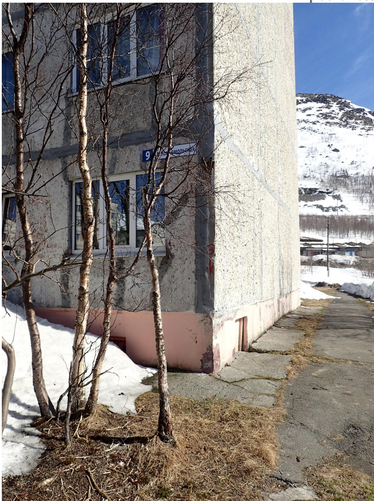
Удаление от угла здания около 30 см, высота размещения от земли более 3 м.
