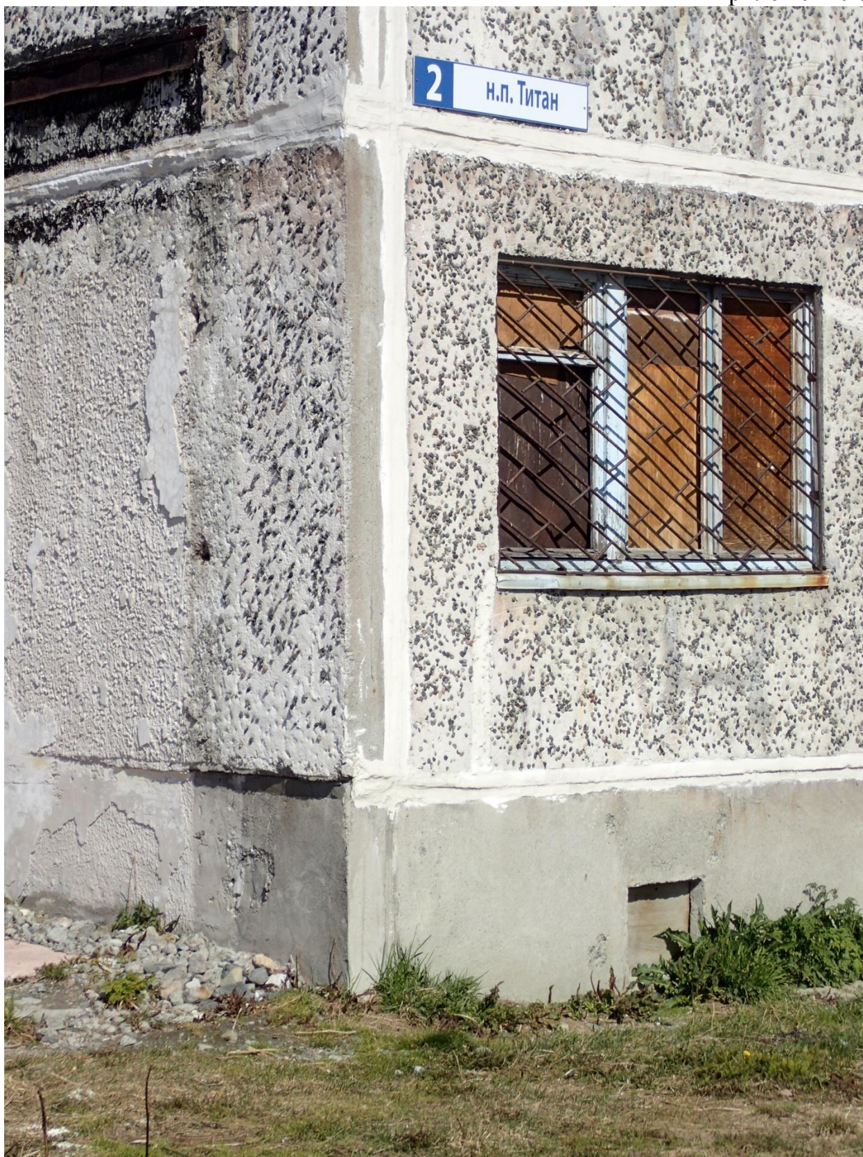
Удаление от угла здания около 25 см, высота размещения от земли более 3 м.
