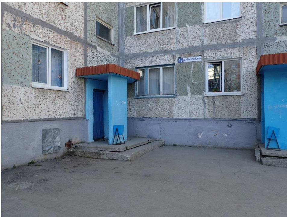
Удаление от угла здания около 1,5 м, высота размещения от земли более 2,7 м, размещено с левой стороны фасада.
