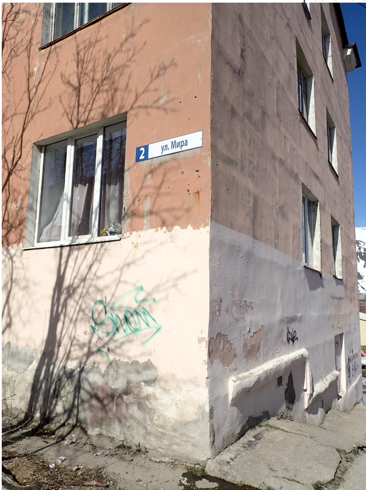
Удаление от угла здания около 10 см, размещено с правой стороны фасада.
