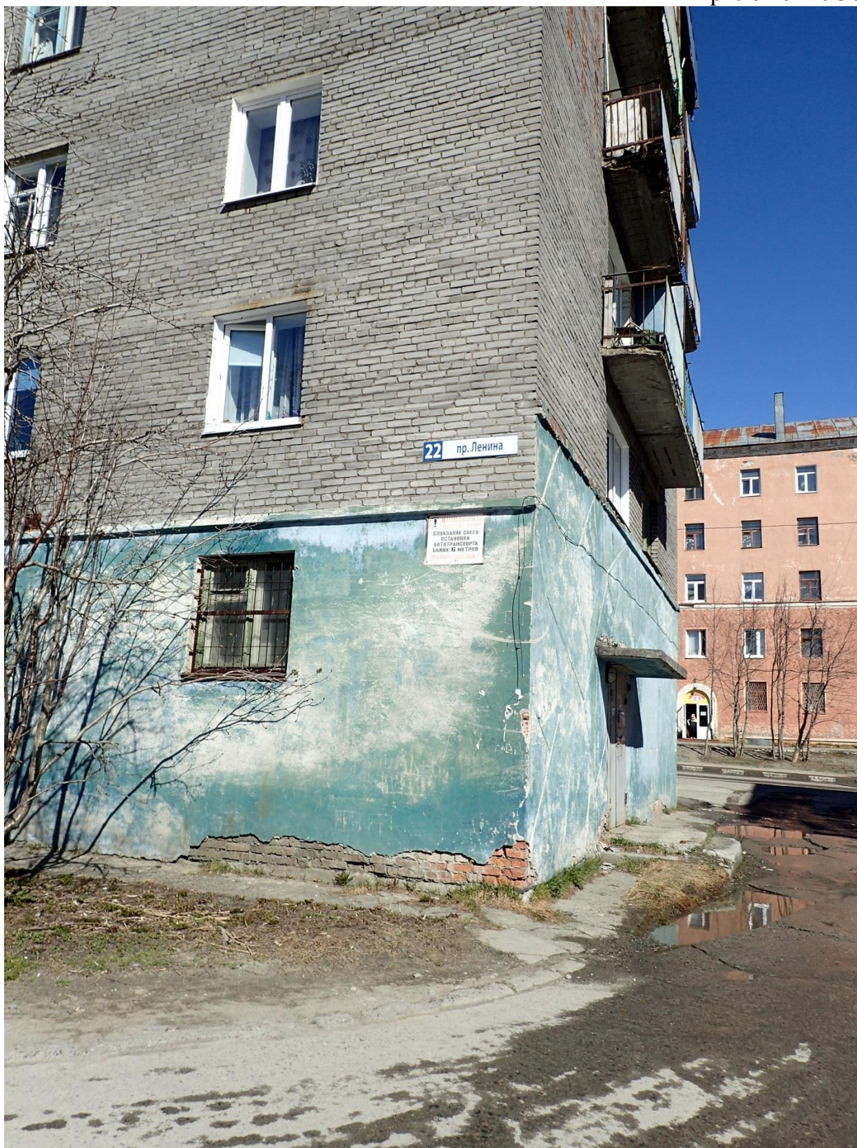
Удаление от угла здания около 20 см, высота размещения от земли более 3 м, размещено с правой стороны фасада.
