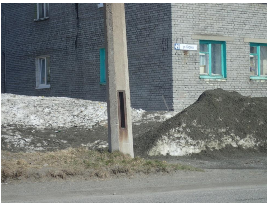
Удаление от угла здания около 5 см, размещено с левой части фасада.
