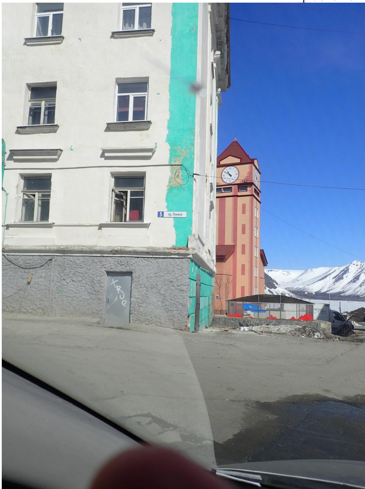
Удаление от угла здания около 15 см
