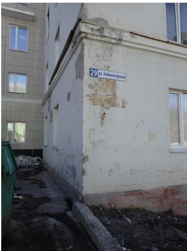
Удаление от угла здания около 15 см, высота размещения от земли более 3,5 м, размещено с левой стороны фасада.
