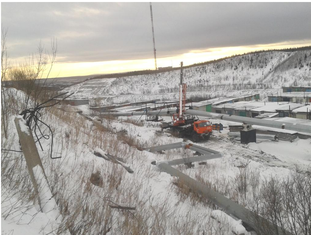
Рисунок 1.3 Строительство тепломагистрали между ТНС-3а и ПНС.
